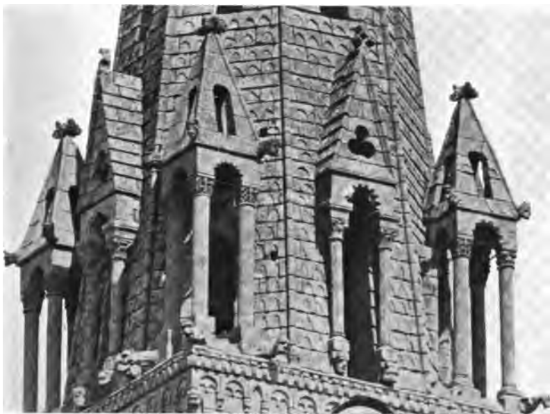
Fig. 51. — Détail d'amortissement de la flèche du clocher de Mogneville (Oise).
